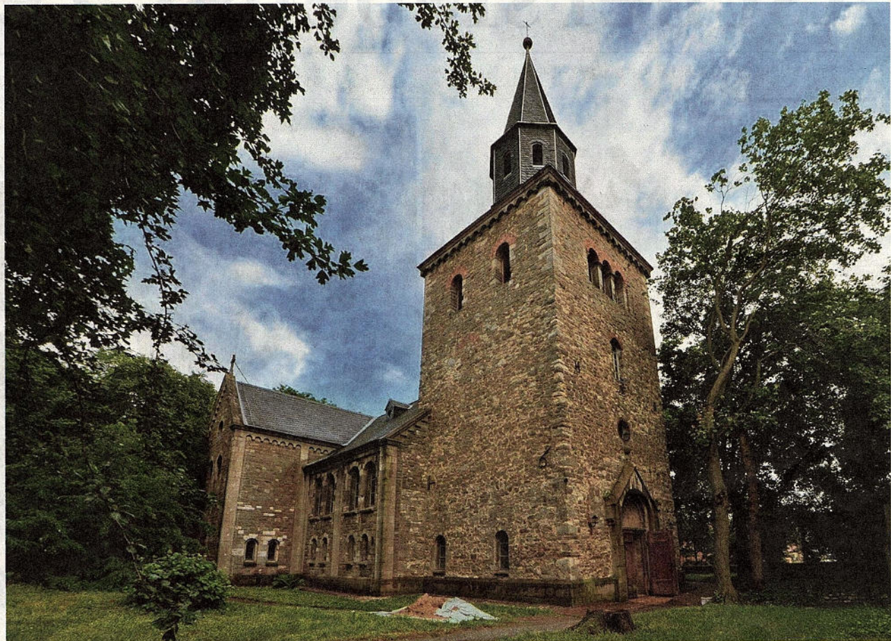
Die Wilslebener Kirche wird derzeit mit Geld aus dem Leaderfördertopf saniert.
